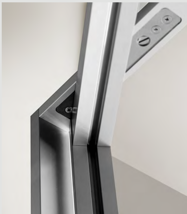
particolare di cerniera superiore incassata nel telaio senza battuta
