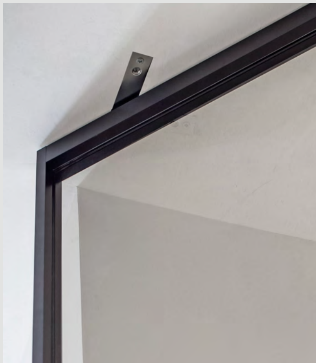
particolare di cerniera incassata a soffitto
