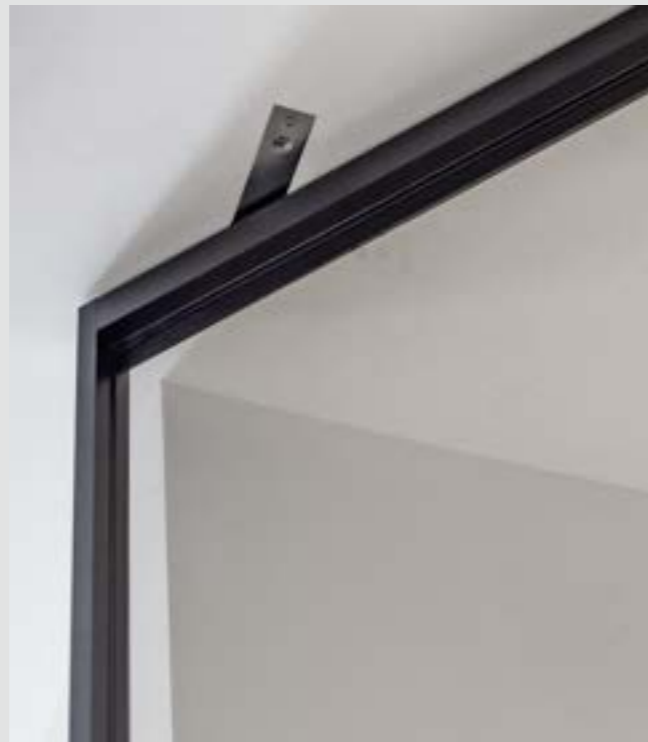
particolare di cerniera incassata a soffitto
