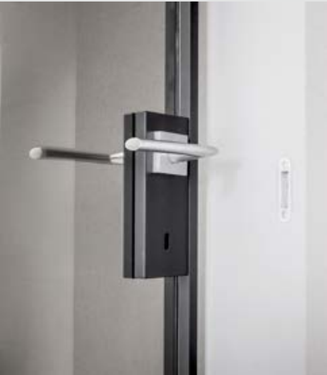
particolare di incontro magnetico incassato a parete
