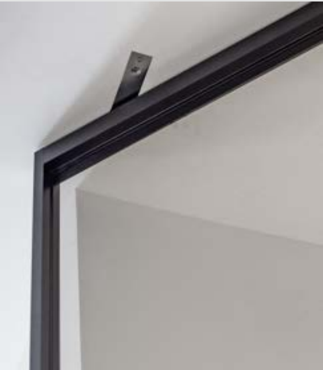
particolare di cerniera incassata a soffitto
